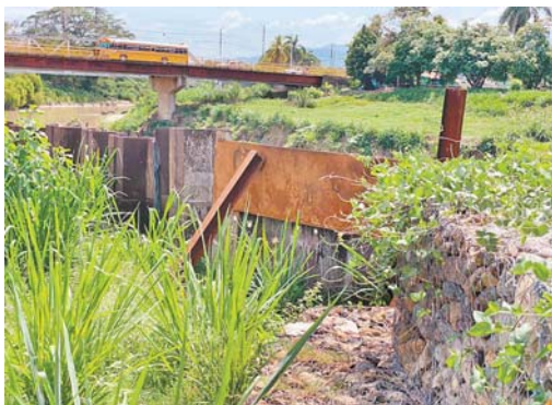
Alrededor de 4.6 millones de lempiras costarán estas obras de protección en La Lima Centro.
