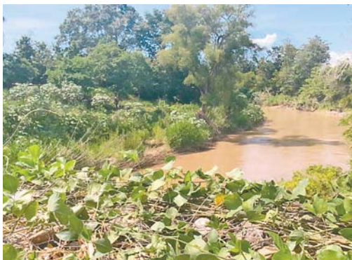
Las actividades a realizar consisten en la rehabilitación de tramos de bordo, protección de margen y mejoramiento de estructura tablestaca.
