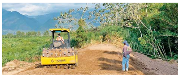
Se espera que las obras ya estén finalizadas para julio, tomando en cuenta el avance de los trabajos.
