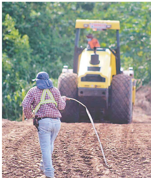
La rehabilitación de los bordos de San Manuel ha generado empleo a los pobladores del lugar.
