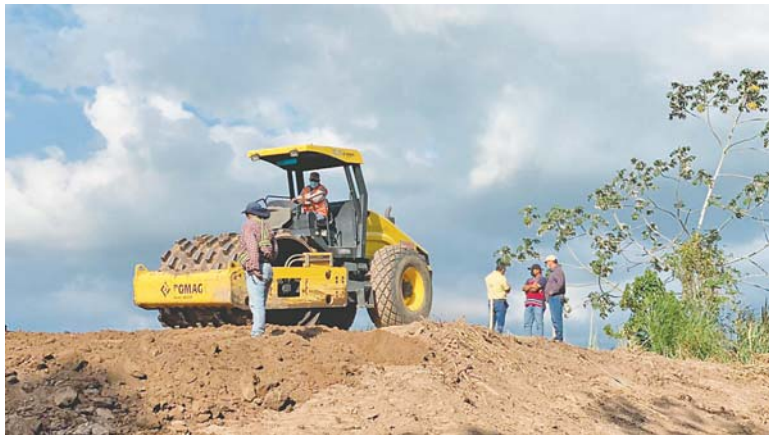
De las 12 roturas de bordo que se necesitan reparar en la zona, ocho ya están finalizadas.
