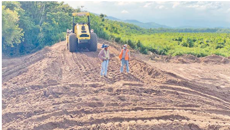
En la zona se hacen supervisiones y recorridos sorpresa para verificar la calidad de las obras.
