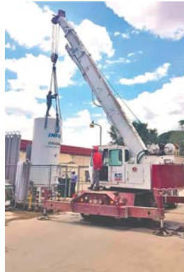
Sustitución de tanque de oxígeno en el Hospital “Gabriela Alvarado”.
