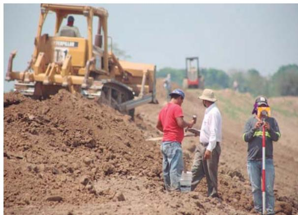
Las obras en el canal Maya consisten en limpieza, acarreamiento, compactación de terreno y reparación de aberturas.
