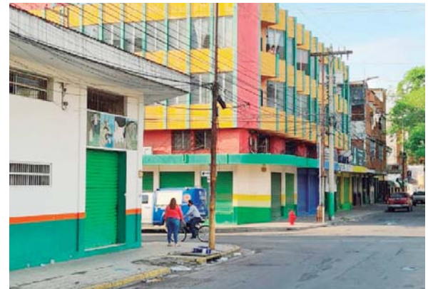
La Policía investiga si el abogado se lanzó o lo tiraron desde la azotea del edificio de establecimientos comerciales.
