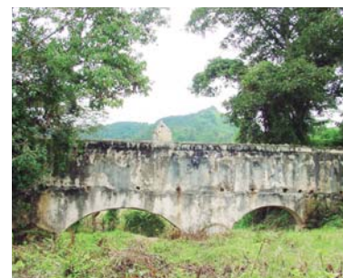
Acueducto Los Arcos, 1776.
