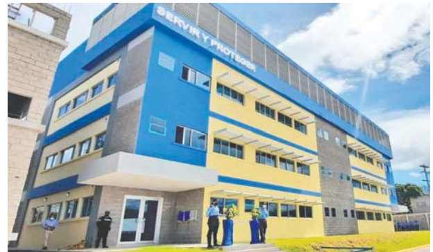
El moderno edificio, diseñado para afrontar el crecimiento poblacional del sector, además de oficinas, también cuenta con áreas de lavandería, cafetería, plaza pública de acceso al complejo y un amplio estacionamiento.
