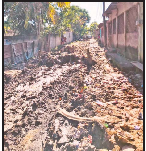
En Chotepe se está reparando el boquete que afectó esa aldea durante las inundaciones por Eta e Iota.
