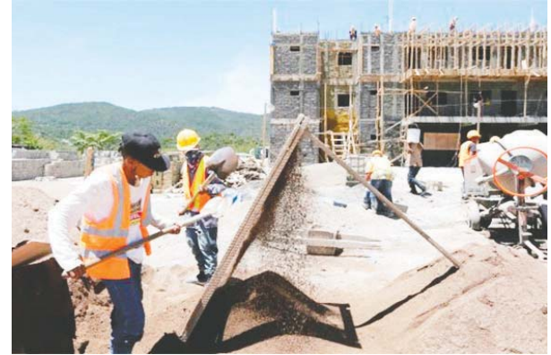
La meta este año en el sector construcción es generar 300 mil plazas.
