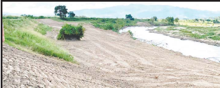
Con una inversión de 10 millones de lempiras se logró reconstruir 13 tramos de los bordos del Valle de Sula.
