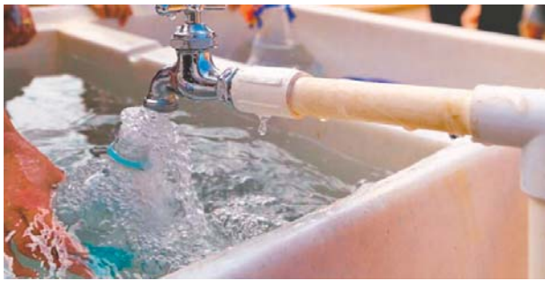
Según autoridades del SANAA, en 2021 se mejorará la distribución del servicio de agua potable en la capital.
