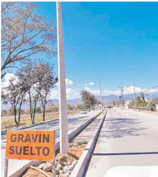
Esta obra podrá ofrecer una ciclovía de concreto.
