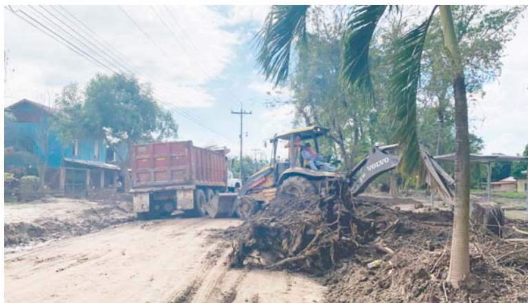
Los equipos de apoyo retiraron los escombros dejados por los huracanes en noviembre.
