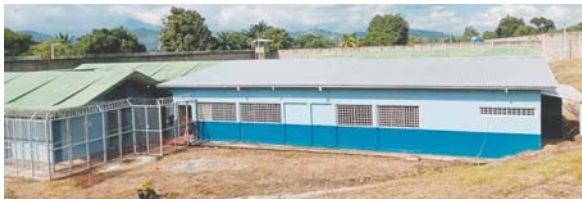
Con las nuevas obras construidas en los centros para menores infractores se busca mejorar su calidad de vida.
