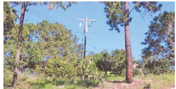
La instalación de los equipos y materiales para el moderno sistema de energía y alumbrado público fueron obra de la comuna de Comayagua.
