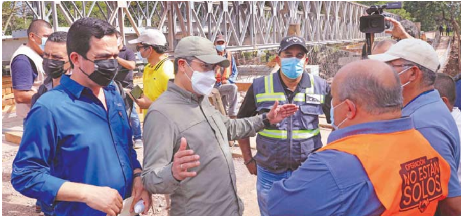
Recientemente, el Presidente Juan Orlando Hernández supervisó las obras de construcción del puente de la Arada, en Santa Bárbara.
