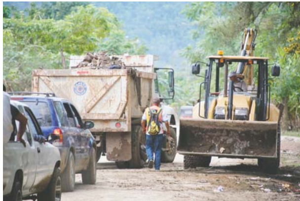
A segunda fase de la Operación “No Están Solos”, las instituciones gubernamentales continúan los trabajos de limpieza en beneficio de los pobladores de Baracoa.
