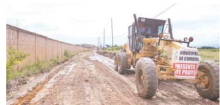
Avanza la reparación de carreteras, puentes y bordos en la periferia de Comayagua.
