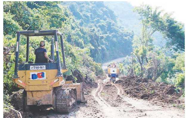
Más de 5,000 viviendas se encuentran afectadas en Santa Bárbara, tras el paso de las tormentas Eta y Iota.
