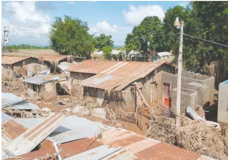
Más de 1,100 viviendas quedaron totalmente destruidas en zonas de riesgo de La Lima.
