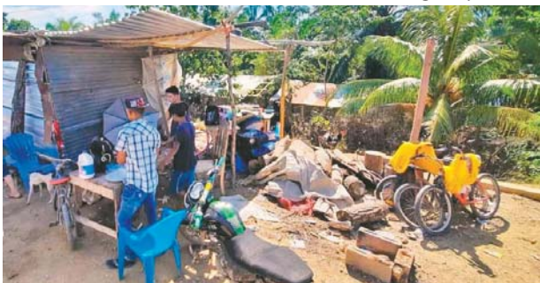
Familias enteras ahora viven en casuchas improvisadas, construidas con plásticos, tablas y láminas de zinc.
