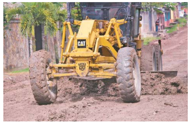
La calle que se está pavimentando sirve de alivio al congestionamiento que enfrentan los conductores de la calle “21 de Agosto”.
