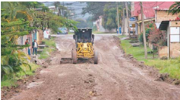
Más de 200 metros lineales se están pavimentando en el barrio El Carmen, de Siguatepeque, Comayagua.
