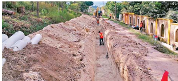
42 familias de la colonia Mata son beneficiadas con la red de alcantarillado sanitario.
