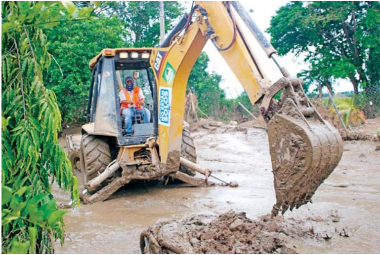
Los trabajos de limpieza continúan a cargo de 100 unidades de maquinaria pesada.
