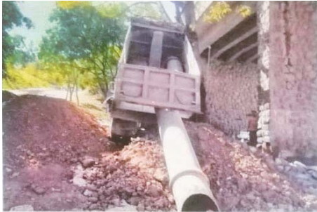
En el 2017, don Pablo Montoya comenzó las obras de relleno del terreno donde construiría su restaurante de mariscos.
