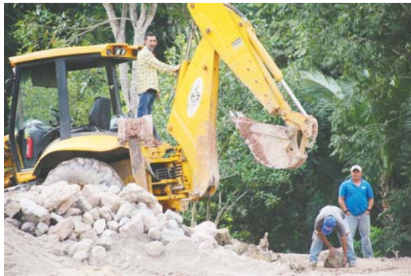
La maquinaria ya trabaja a paso redobrado para construir las casas.
