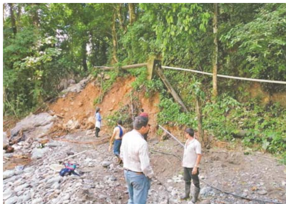
Las torrenciales lluvias de “Eta” e “Iota” provocaron severos daños a las líneas de conducción del sistema de agua potable de Catacamas, Olancho.
