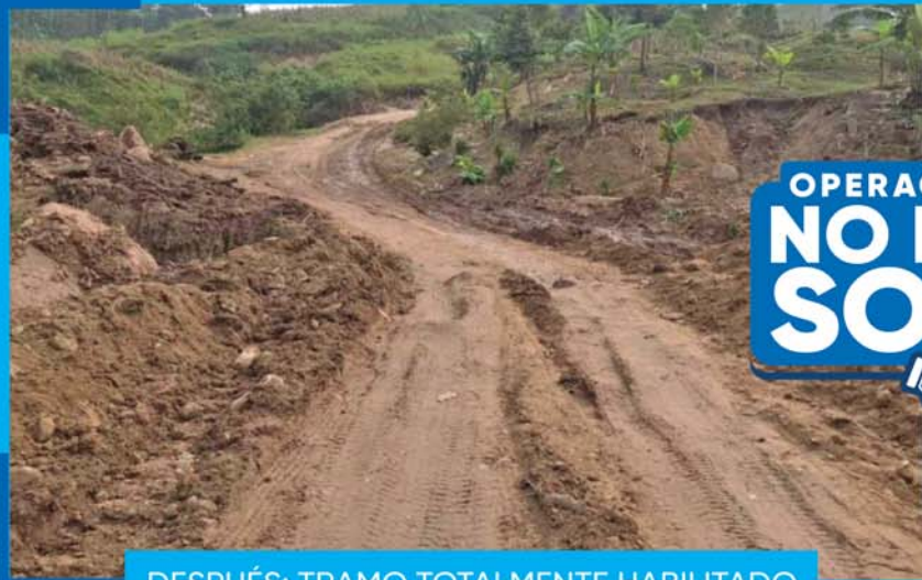
DESPUÉS: TRAMO TOTALMENTE HABILITADO
