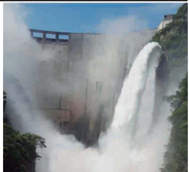
"Cajón" descargó 500 metros cúbicos de agua por segundo.
