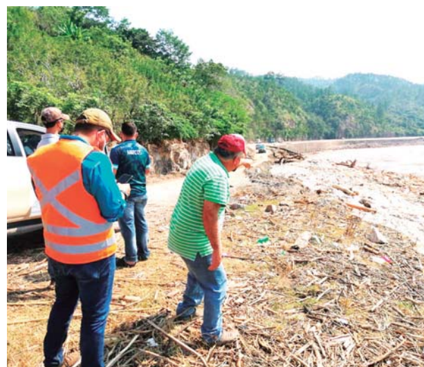
Los daños se cuantifican en puentes destruidos, casas colapsadas, destrucción en los sistemas de agua y energía eléctrica y pérdidas de cultivos.
