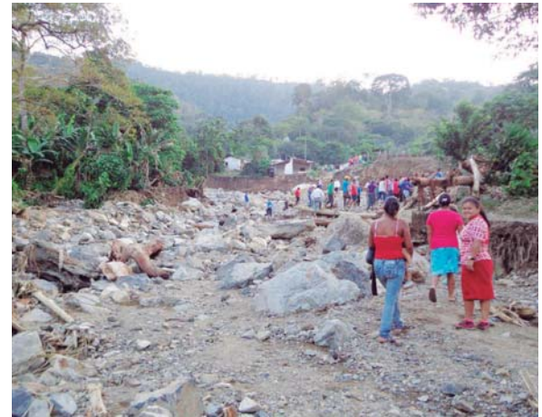
Como el cauce de un río ha quedado destruida la carretera principal de Santa Fe, Trojes.
