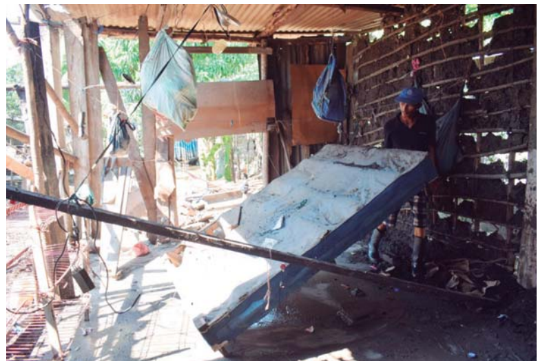
Algunas casas comienzan a ser habitadas aún en malas condiciones y prácticamente a la intemperie.
