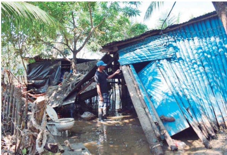
Las pequeñas viviendas construidas de láminas de zinc y algunas de nylon o batreque quedaron destruidas.
