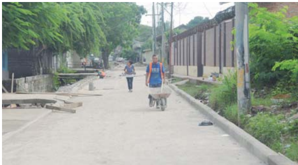
Los trabajos de pavimentación están en un 90 por ciento, próximo a ser entregado el trabajo.
