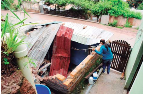
En la colonia Nueva Suyapa, la saturación de agua en el suelo, debido a las lluvias, provocó daños en algunas casas.
