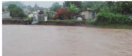
Los ríos Güique y Celam amenazan los barrios y colonias adyacentes a sus caudales.
