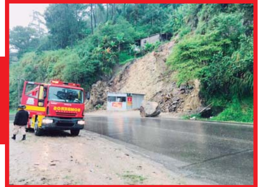
Una enorme roca se desprendió ayer, en la salida hacia Ocotepeque, debido a la saturación de agua en el suelo.
