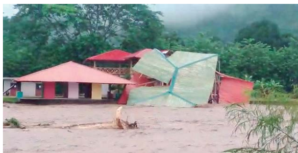
Las embravecidas aguas del río Talgua destruyeron un restaurante construido cerca de una orilla.
