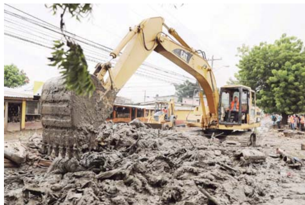
Las retroexcavadoras enviadas por el gobierno han animado a los habitantes, al ver que las calles van quedando limpias.
