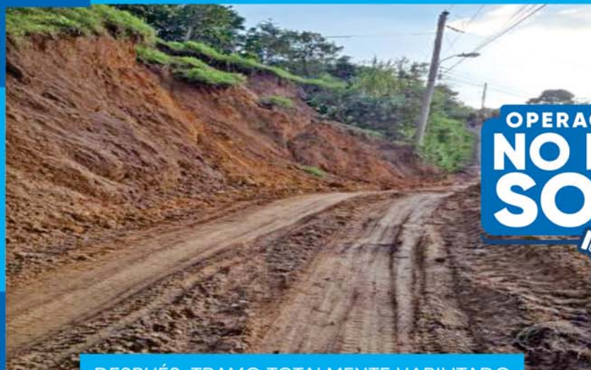
DESPUÉS: TRAMO TOTALMENTE HABILITADO
