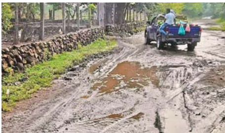
Las lluvias han contribuido a deteriorar aún más la carretera hacia la zona de El Trapiche y comunidades adyacentes.
