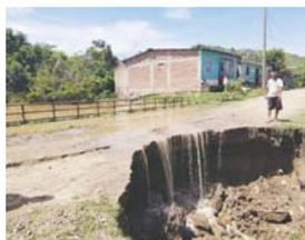
Varias cajas puente y alcantarillas sufrieron daños debido a las torrenciales lluvias.
