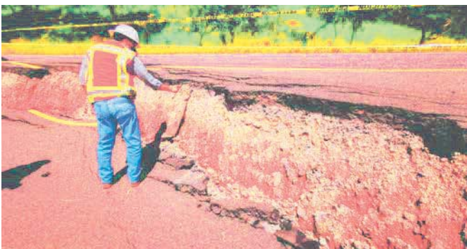
Por el momento la circulación en el lugar se encuentra restringida a un solo carril. (KSA)
