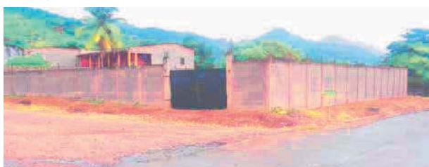
El terreno para la construcción de la clínica de hemodiálisis está ubicado en la colonia La Pradera, de Catacamas.
