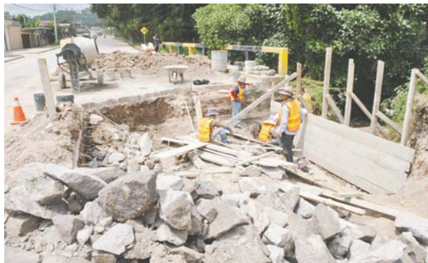
Los trabajos en la losa de concreto que se ejecutan, incluirán el cambio del material por completo, debido a lo inestable del terreno.
