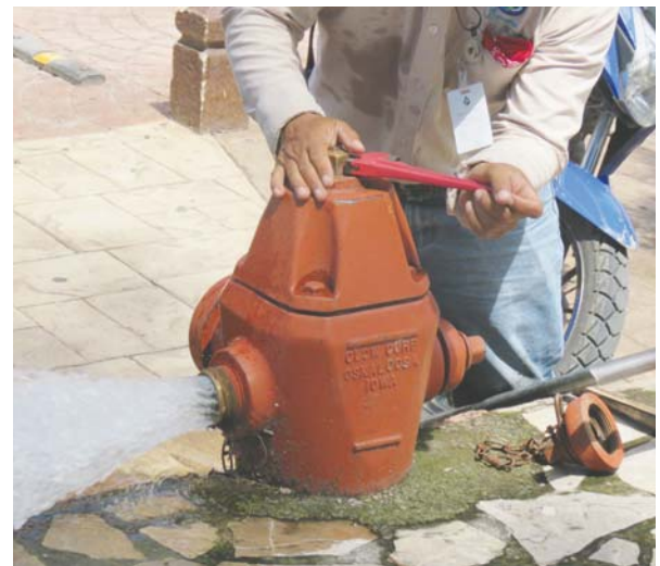
Revisan estado de hidrantes contra incendios y expansión de la ciudad en Siguatepeque.
