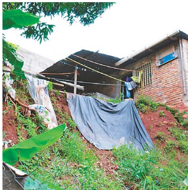
Más de tres viviendas corren el riesgo de colapsar en unas horas, si no se construyen obras de mitigación en el lugar.
