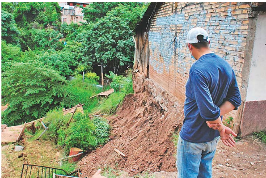
El deslizamiento de tierra en un sector de la colonia La Esperanza se debe a la saturación de agua en el suelo, producto de las lluvias.
