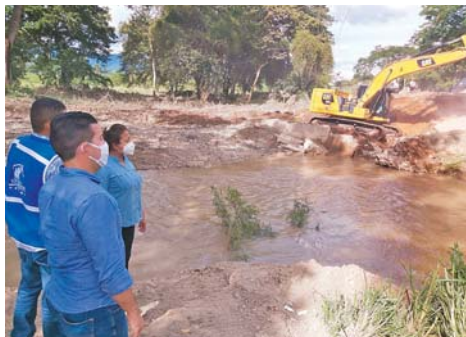
Con maquinaria pesada de la municipalidad de Juticalpa y el gobierno central se trabajó en rehabilitar el paso por el sector del puente de Galeras, Lepaguare, Olancho.
