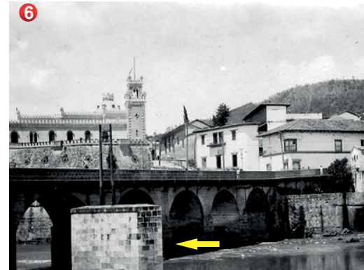
La flecha indica el diamante que se construyó en 1908 para evitar daños por las crecientes del río.
