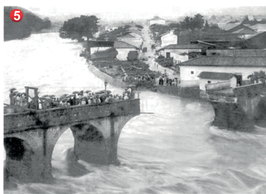
La riada de 1906 destruyó los arcos de la aproximación a Comayagüela.
